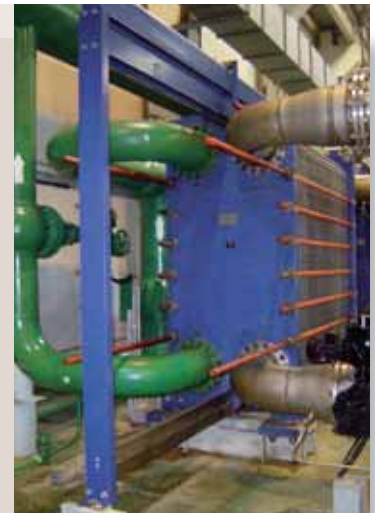
На ТАЭС используется 46 разборных пластинчатых теплообменников Альфа Лаваль.
